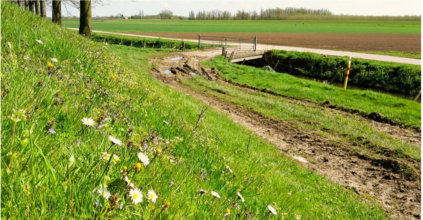
Op het eerste gezicht een eenvoudige dijk, maar later zou blijken dat dit één van de meest bijzondere dijken uit de Zuidwestelijke Delta is. Molenpoldersezeedijk, Rhoon. 10 april 2016.
